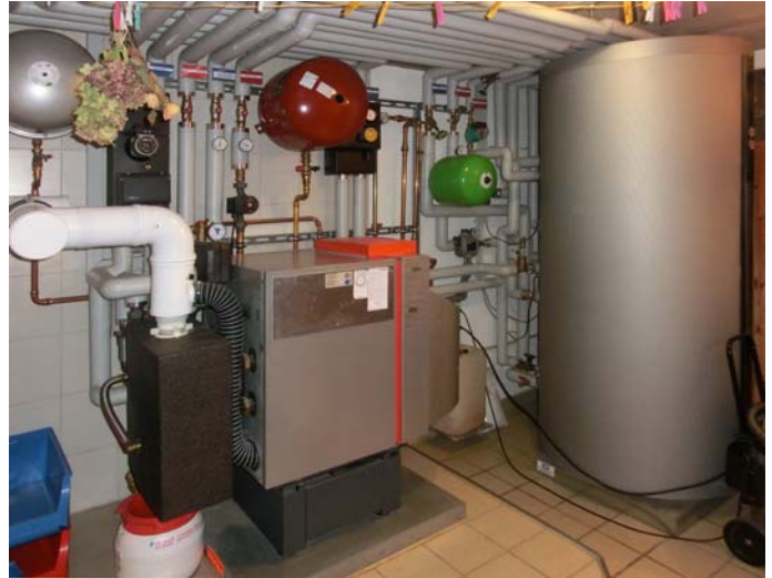
Bild: Öl-Brennwertkessel und Warmwasserspeicher (v.li.), © REG.eV
